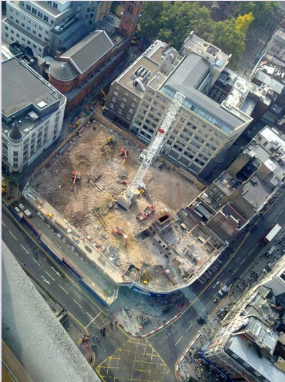
Bouwput voor de spoorkruising Tottenham Court Road.
